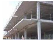
Entramado de pilares y vigas en hormigón armado como elementos resistentes, forjados unidireccionales de viguetas prefabricadas de hormigón y bovedilla cerámica y/o hormigón, cuerpos volados en hormigón visto, escaleras de hormigón revestidas con madera en acabado mansonia o similar barnizada y tratada.
